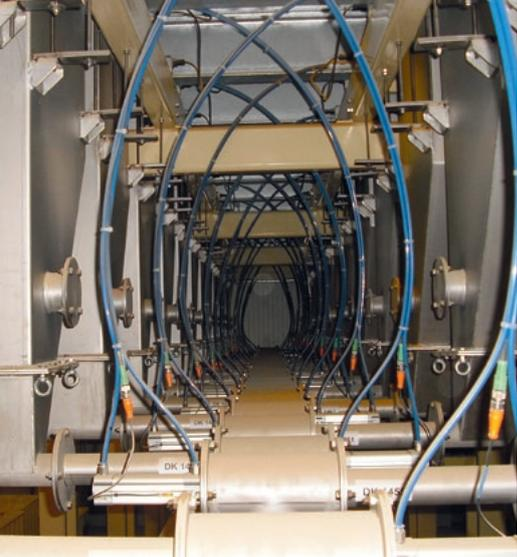
Schnellschlussventile DV | Quick-action valve DV
